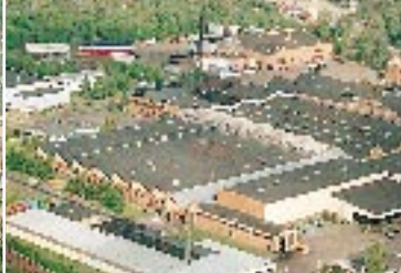
Falun Tillverkning, montering och målning av axlar.
